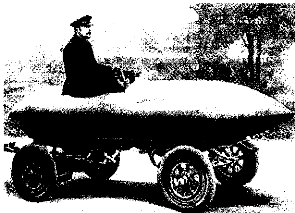
Рис. 1 Первый автомобиль, преодолевший отметку в 100 км/ч (1899 г.). Приводился в движение двумя электромоторами суммарной мощностью 67 л.с. Масса – 1000 кг. Максимальная скорость 105 км/ч.
